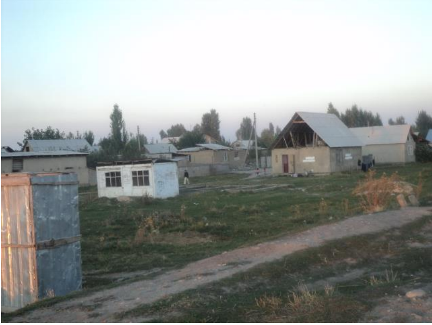
Resim 4. Alt yapıdan yoksun konutlar
